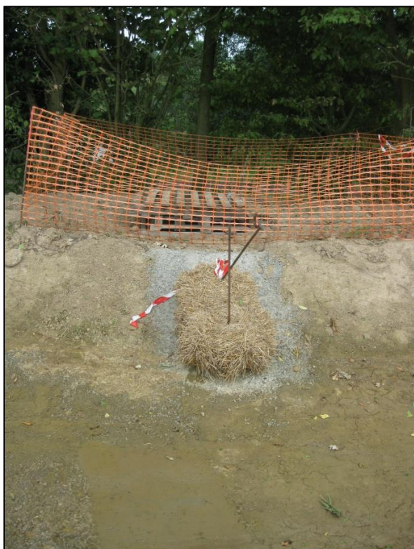
Photo 9 : Emplacement du filtre à particules fines (botte de paille) pendant la phase des travaux au niveau du bassin d'orage
