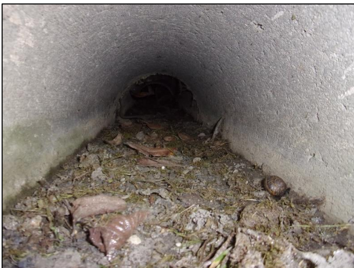
Photo 2 : Vue d'un réseau à curer – Réseau Ø250 de la rue de la Brûlerie
