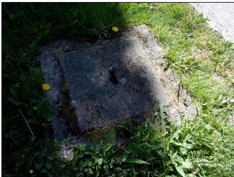
Photo 4 : Vue d'une dalle béton non accessible
