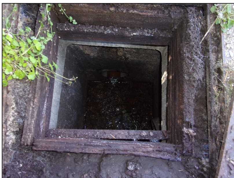
Photo 8 : Planches de coffrage à retirer – Lavoir de la rue du Saint-Père
